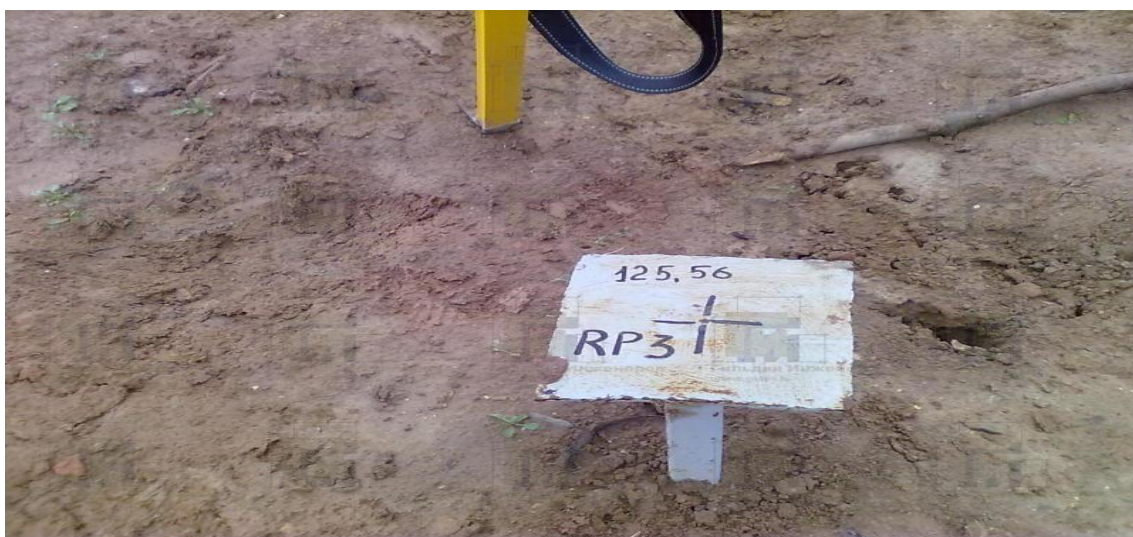
9 Сурет – Тұрақты репер орнатудағы темір бекітпені пайдалану
